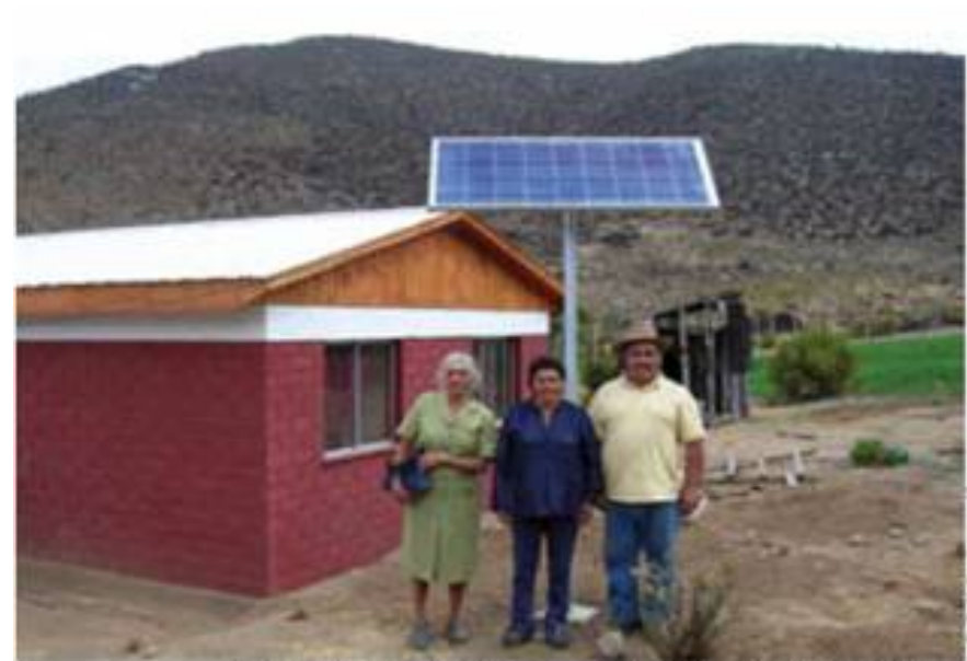
Proyecto Fotovoltaico, Región de Coquimbo
